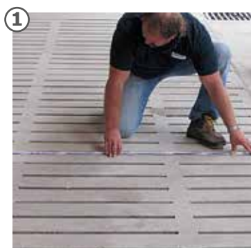
il pavimento grigliato viene misurato
